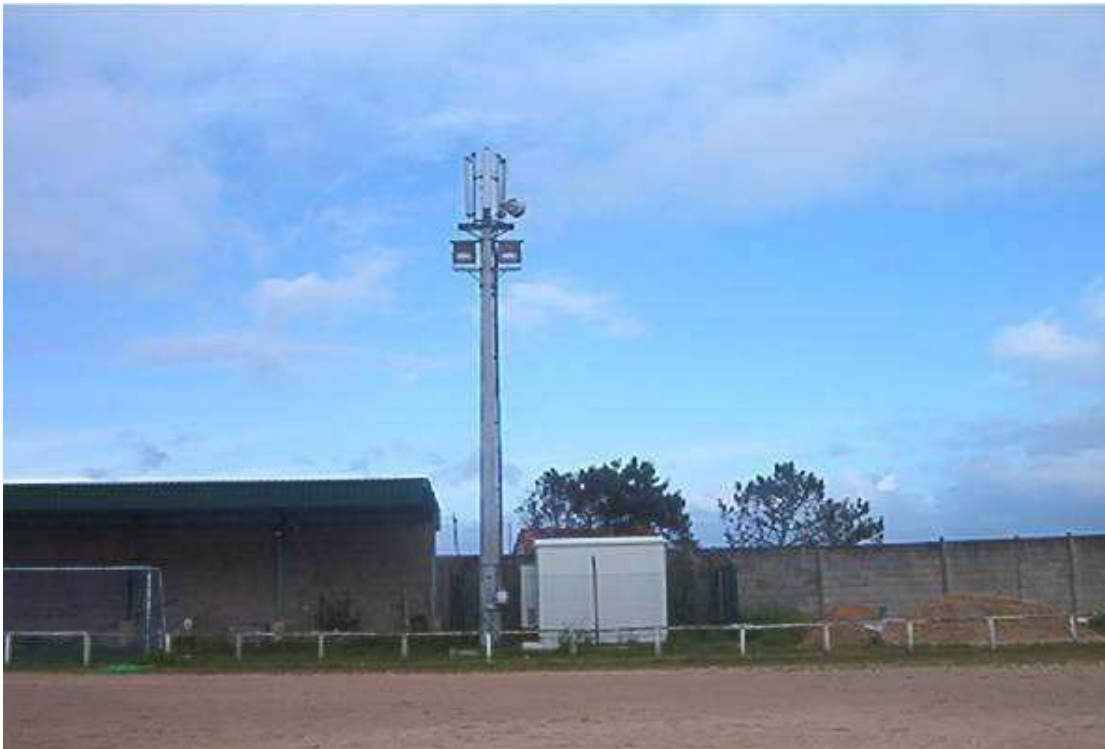
Instalación de antenas sobre mástil de iluminación de campo de fútbol.
