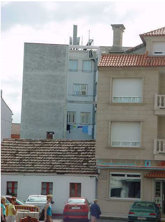
Mástil tubular con antenas tipo panel sobre cubierta de edificio.
