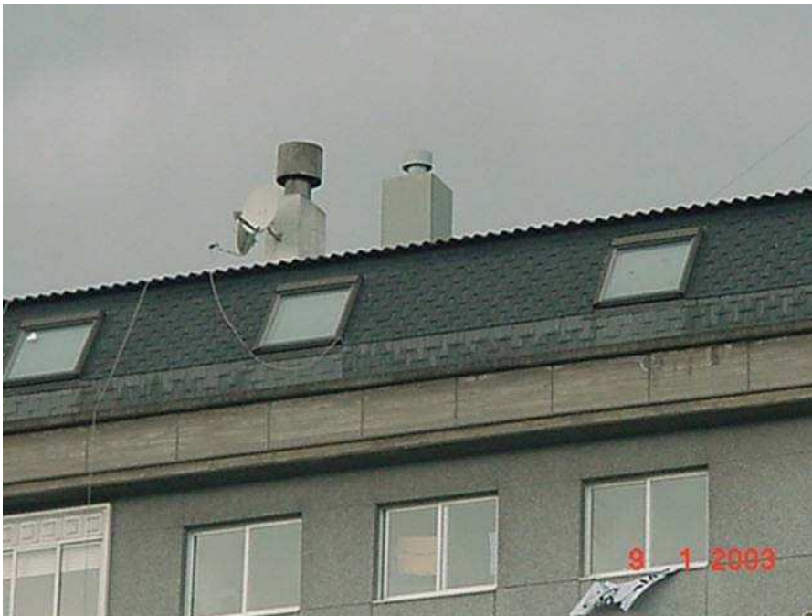
Antenas ocultas en carcasa simulando chimenea rectangular (la de la derecha).
