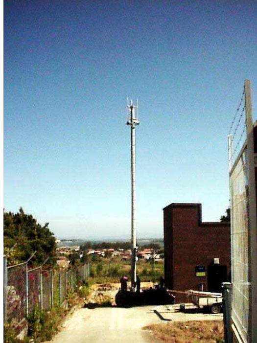
Mástil tubular de hormigón.
