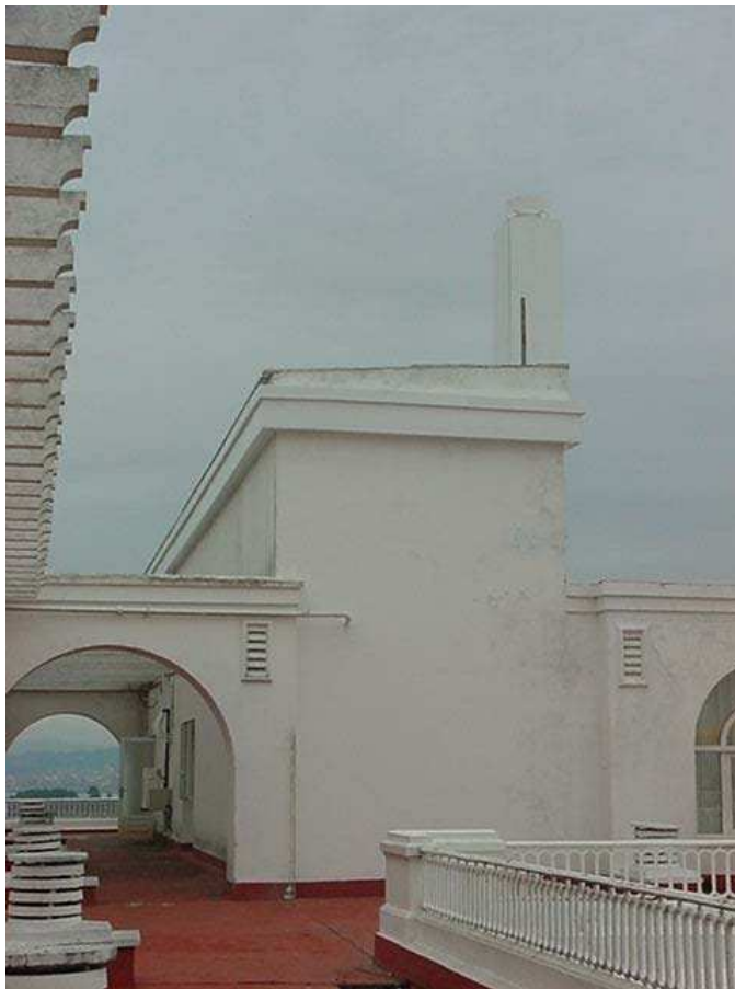
Antenas ocultas en carcasa simulando chimenea rectangular, adosada a casetón existente.
