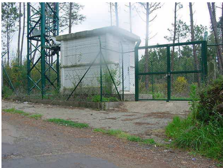
Ejemplo de estación base tipo rural, con caseta prefabricada y mástil de celosía de acero.
