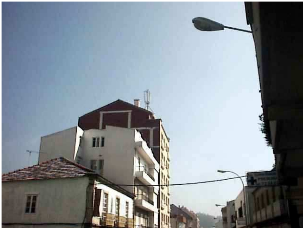
Mástil tubular con antenas tipo panel sobre cubierta de edificio.
