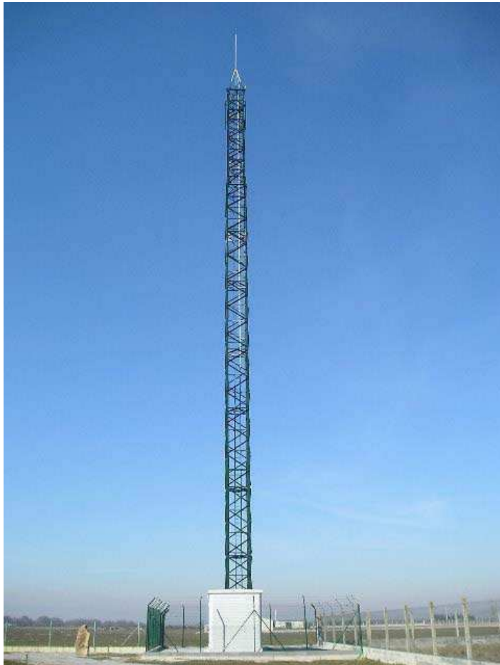
Ejemplo de estación base tipo rural, con caseta prefabricada y mástil de celosía de acero.
