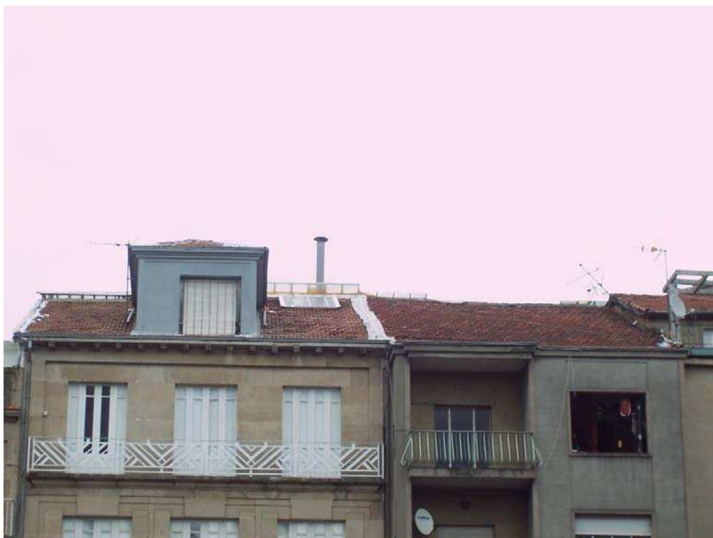
Antena en forma de chimenea tubular sobre casetón existente.
