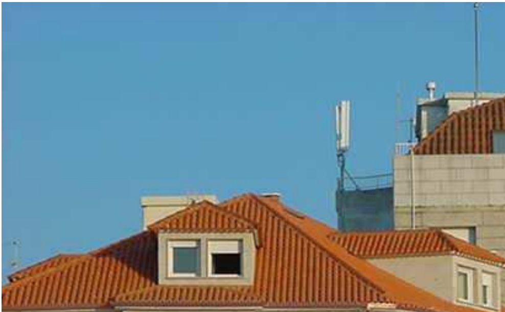
Mástil tubular con antenas tipo panel sobre cubierta de edificio.
